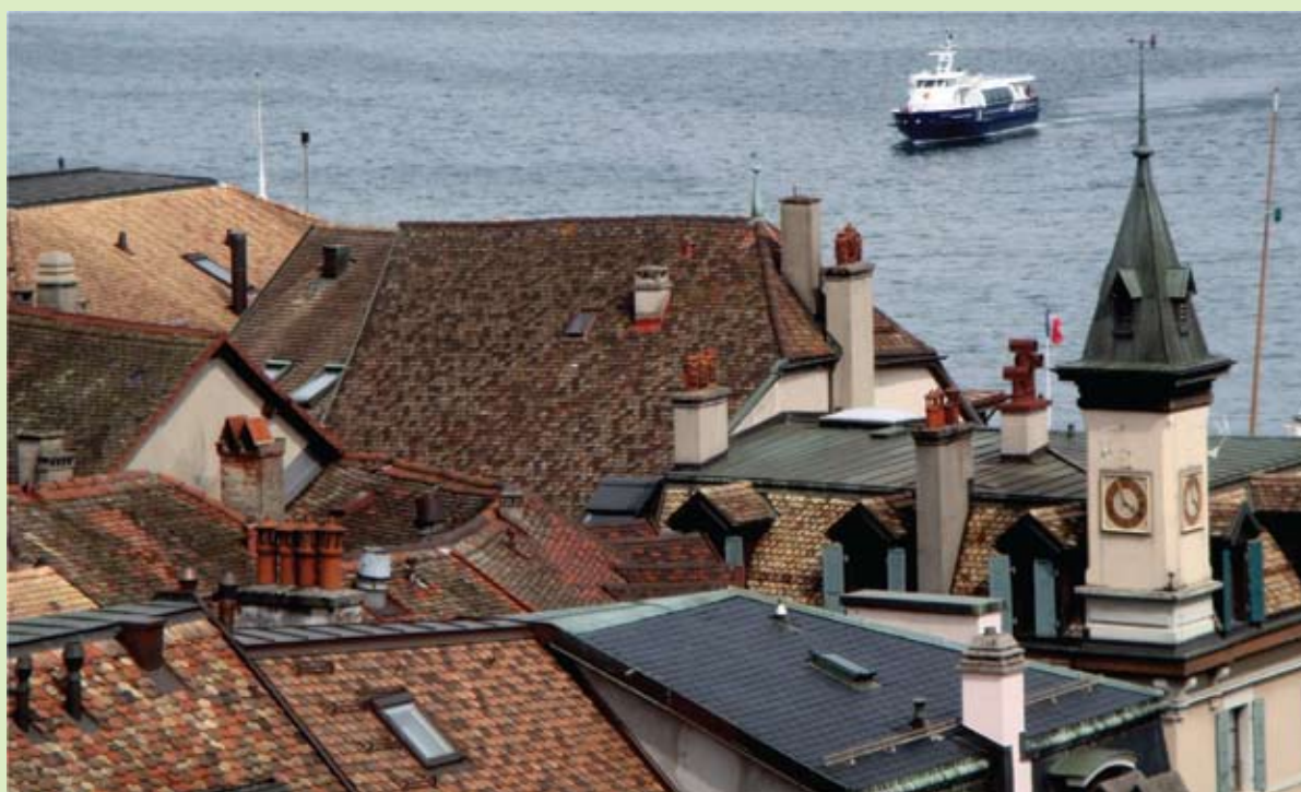
Telhados da cidade velha, Nyon (Suíça)
